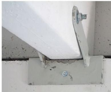
Il tipo di intervento consiste nella posa in opera di **piastre di collegamento** solaio-capriata.
